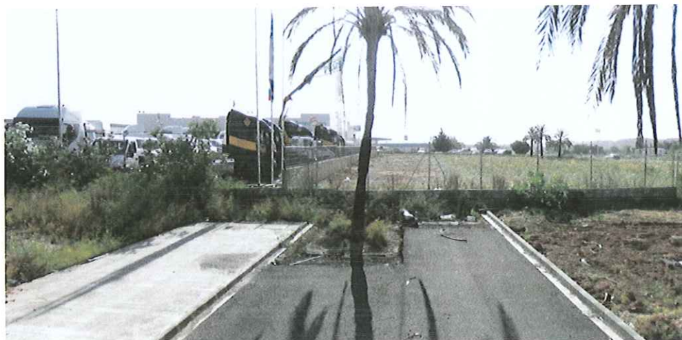
Vial urbanizado correspondiente al ámbito del sector 2, sin continuidad en el sector 1.
