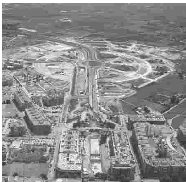
FOTO AÉREA DURANTE LOS TRABAJOS DE URBANIZACIÓN
