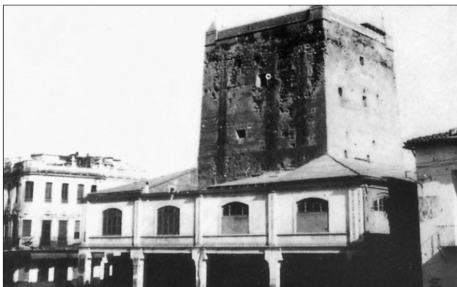
La Torre con su famoso porche. En ella se albergaba el juzgado y el calabozo.
